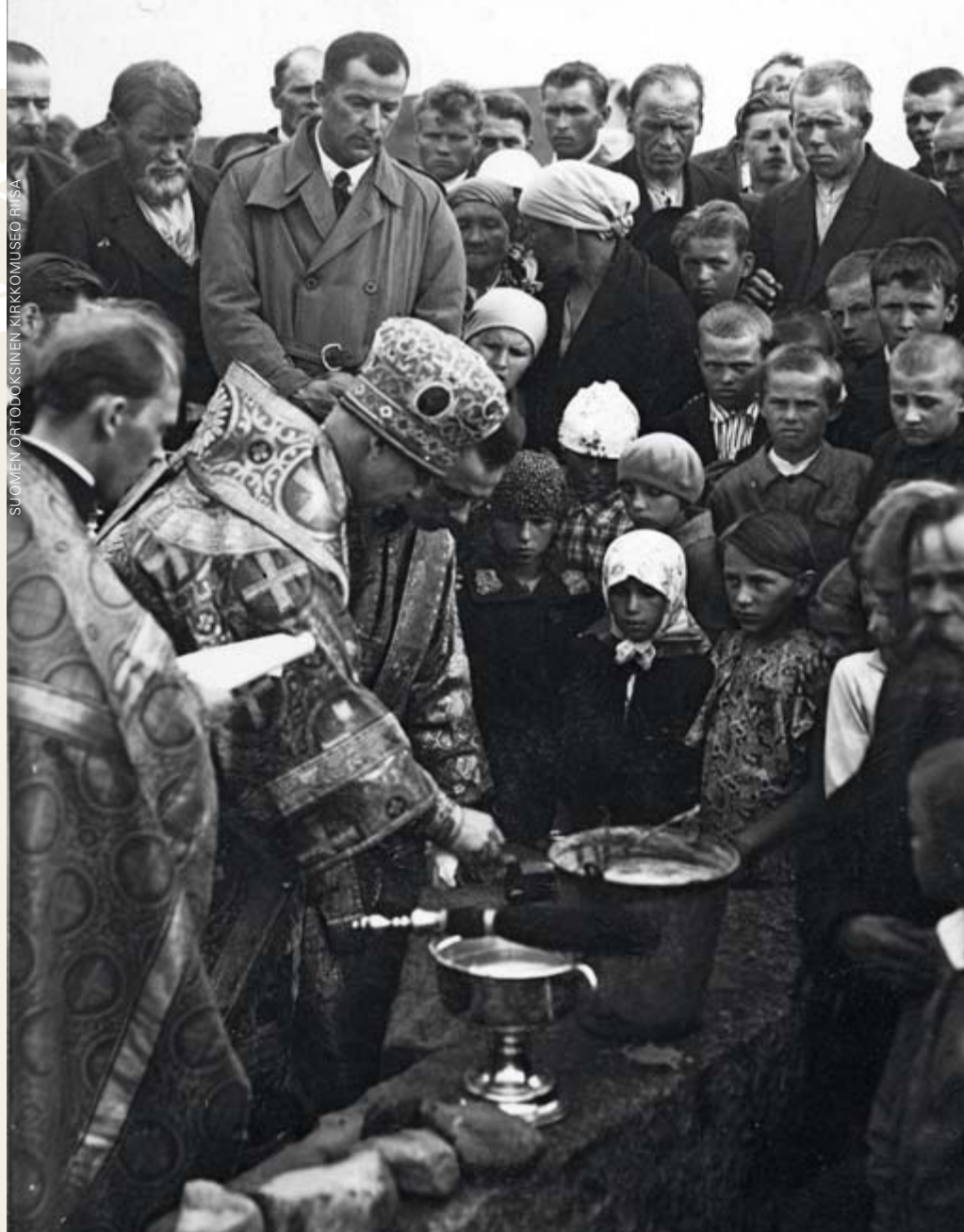
Kuvassa arkkipiispa Herman muuraa peruskiveä Suojärven Leppäniemen kirkon rakennustyömaalla.
